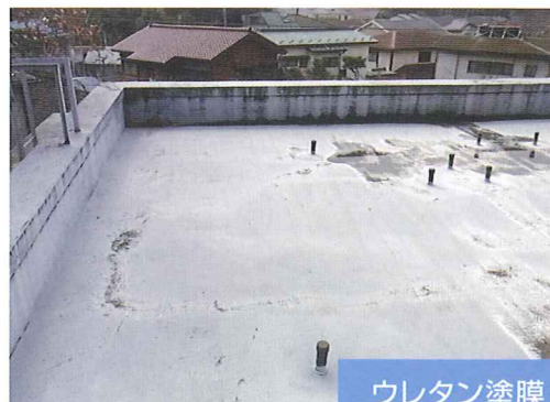
■ウレタン塗膜防水の脱気筒設置例
