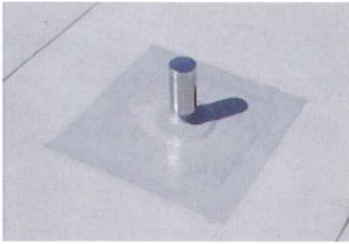
自然換気型脱気筒 (ステンレス製)
